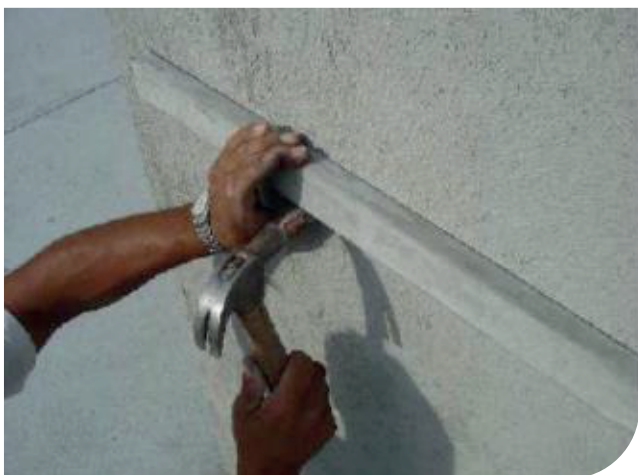
Fixação da régua metálica
