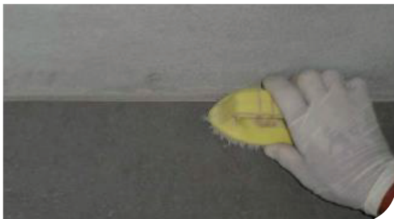
Limpeza da junta de dessolidarização
