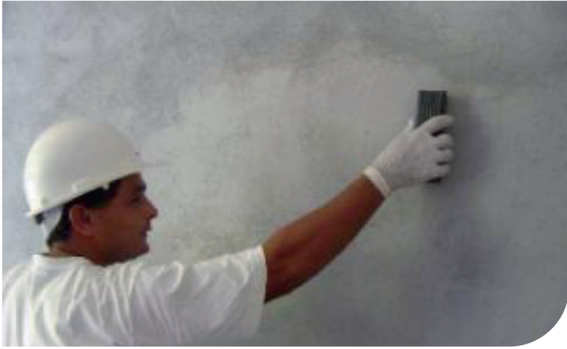
Limpeza da parede com escovas de cerdas de nylon
