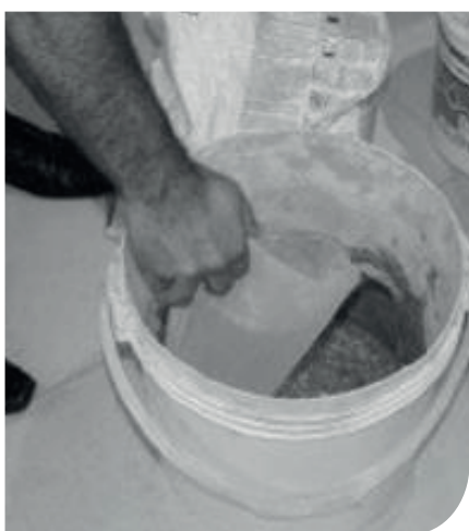
Preparo da argamassa colante – adição da água
