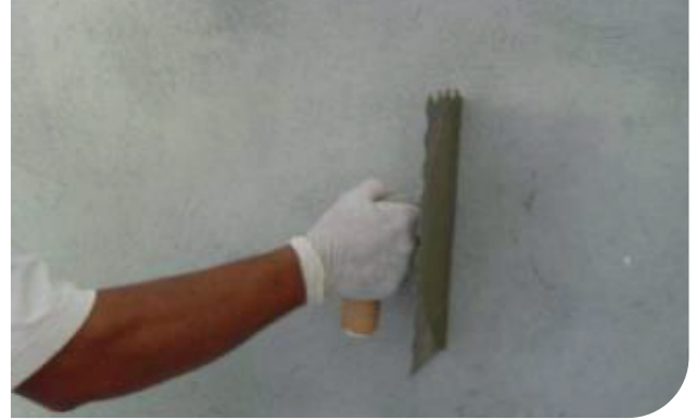
Remoção de objetos aderidos com espátula metálica
