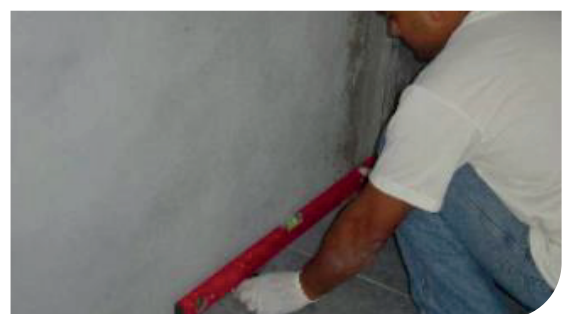
Nivelamento dos calços
