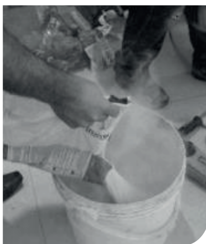
Preparo da argamassa colante – adição do pó
