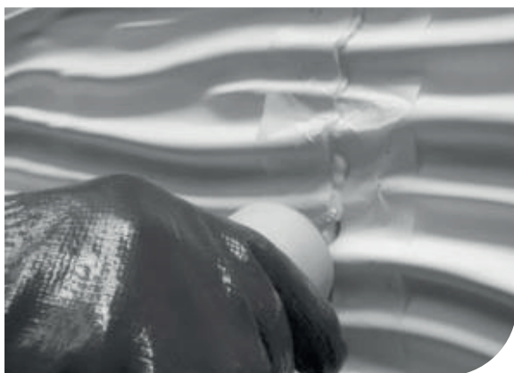
Aplicação do rejunte com bismaga
