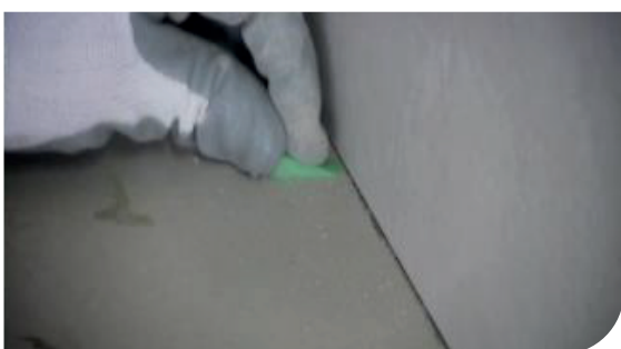
Colocação dos calços para apoio das peças
