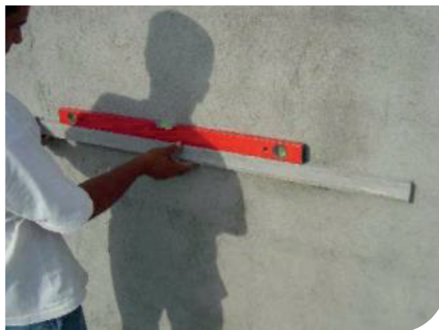
Conferência do nível da régua metálica
