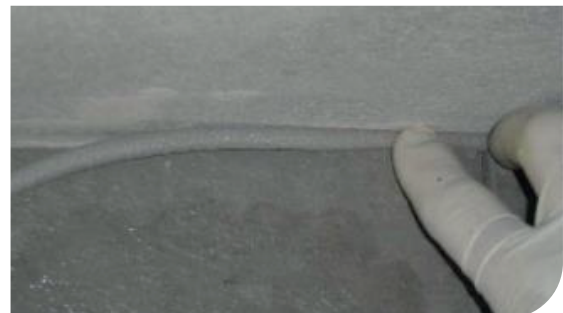
Inserção do limitador de fundo de viga
